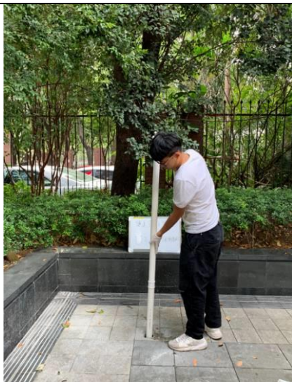
U3 地下水建井照片
