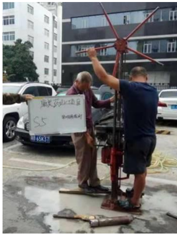
S5 土壤钻孔照片
