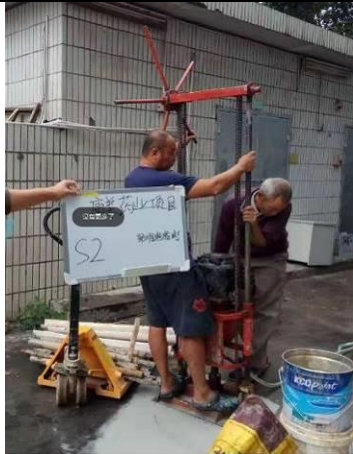
S2 土壤钻孔照片
