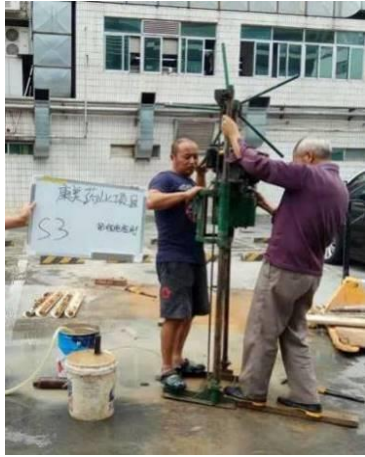
S3 土壤钻孔照片
