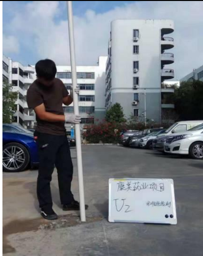
U2 地下水建井照片
