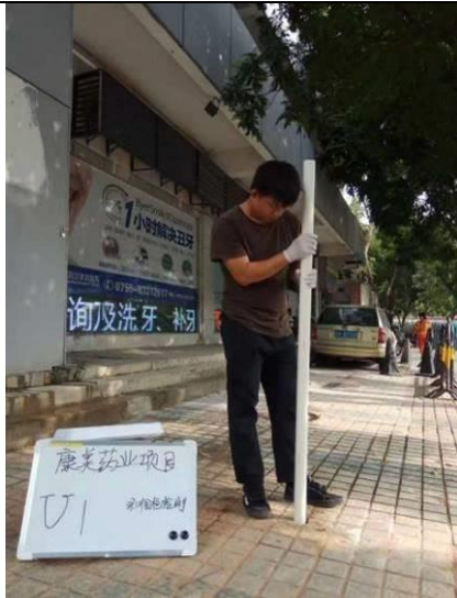
U1 地下水建井照片
