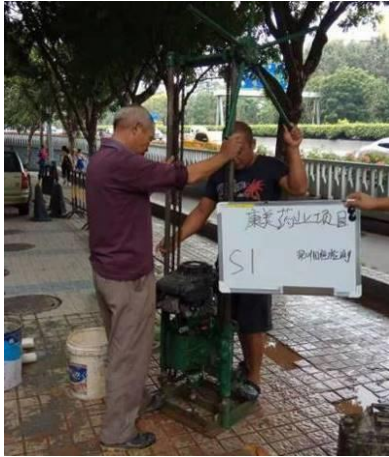
S1 土壤钻孔照片
