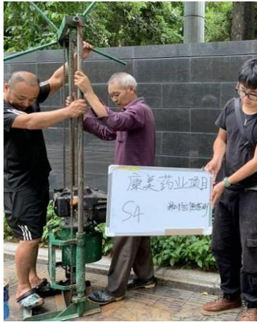
S4 土壤钻孔照片
