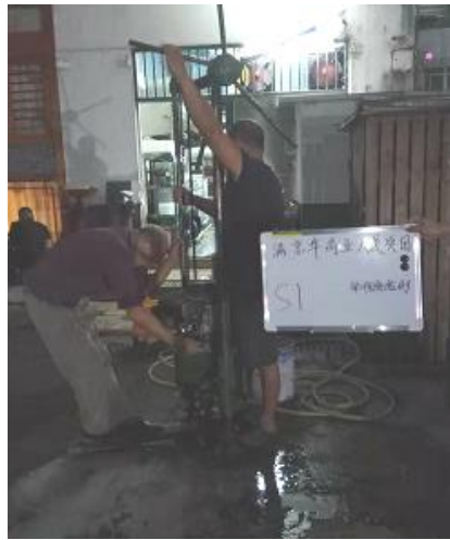
S1 土壤钻孔照片
