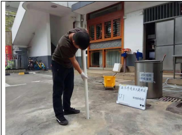
U1 地下水建井照片
