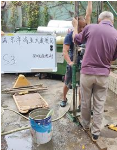
S3 土壤钻孔照片
