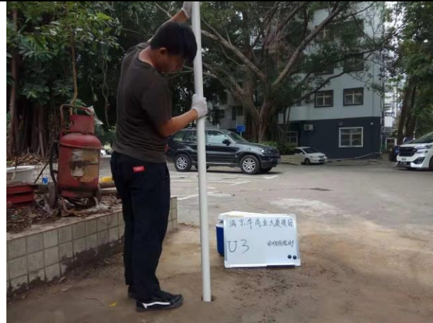
U3 地下水建井照片
