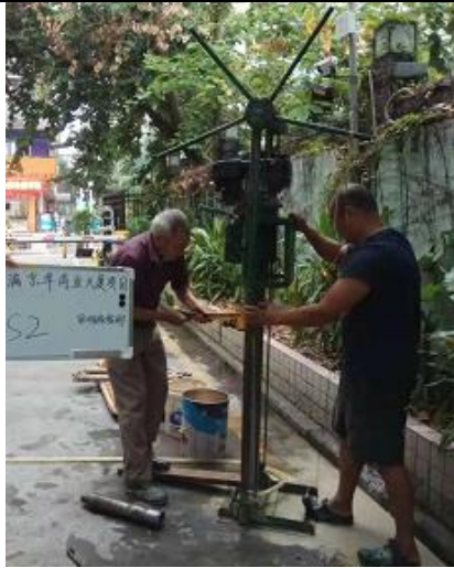
S2 土壤钻孔照片
